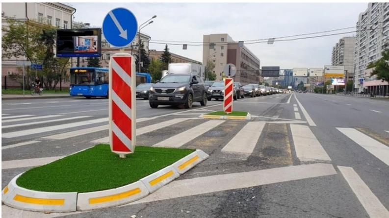
Рис. 2. Модульный островок безопасности в Москве
